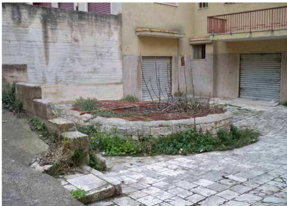
Fig. 3 – L'imbocco dell'inghiottitoio di Via Mater Domini (foto Vincenzo Manghisi)
